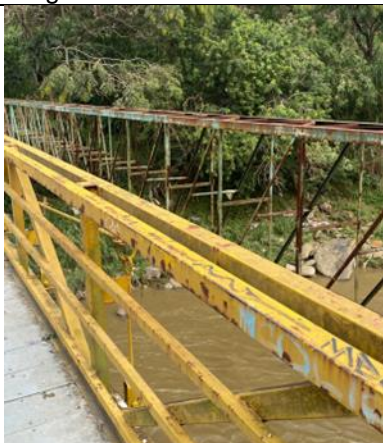
Foto No. 13- Pasamanos del puente colgante.
