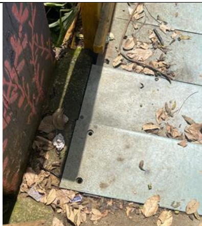
Foto No. 15- Piso en madera plástica del puente colgante.
