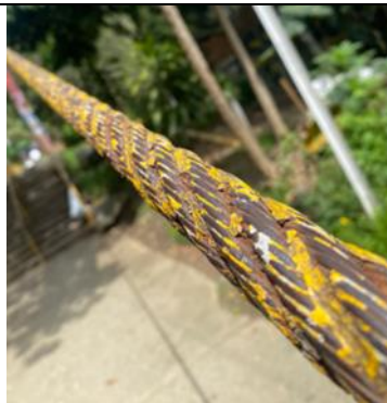
Foto No. 12- Cable principal del puente colgante.
