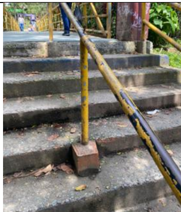
Foto No. 14- Pasamanos en escaleras del puente colgante.
