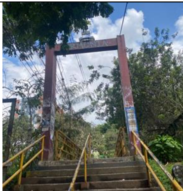
Foto No. 11- Pórtico de soporte de tirantes puente colgante.
